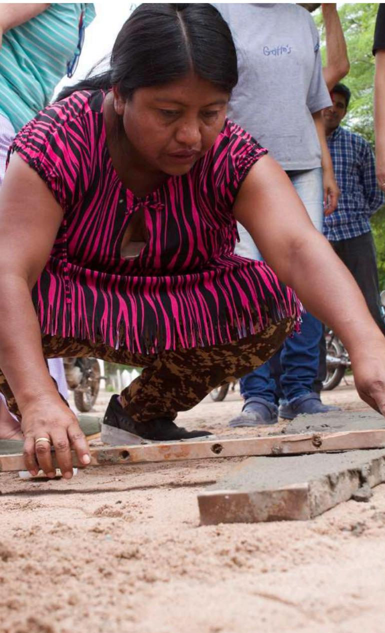
Las cisternas de Placa, se realizan mediante la construcción de moldes de cemento, que luego son utilizados para crear la estructura de la cisterna. Esta tecnología permite almacenar hasta 16.000 litros de agua y se puede construir en tres días. (INTA, 2014: pág 8). Es una cisterna ampliamente difundida en el Semiárido Brasileiro, y que en Argentina a ganado terreno en los últimos años a partir del Programa SEDCERO. (Programa SedCero, Argentina)
